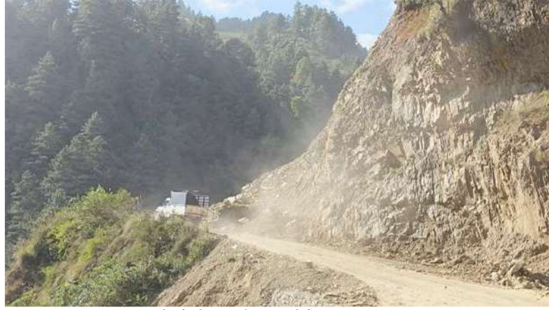
निर्माणधिन 'फाखेल-मातातीर्थ-सतुंगल' सडक।
