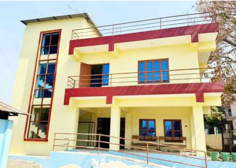
हेटौँडा-५ को नवनिर्मित वडा कार्यालय भवन ।
