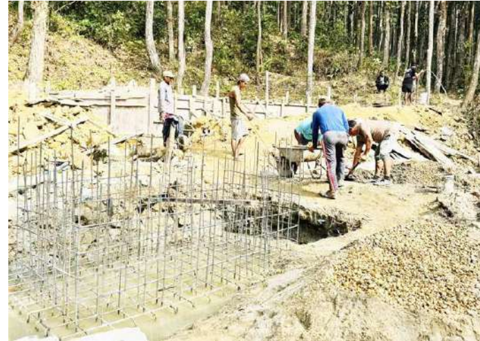
खानेपानीको मुहानमै ट्याङ्की निर्माण गरिँदै।
