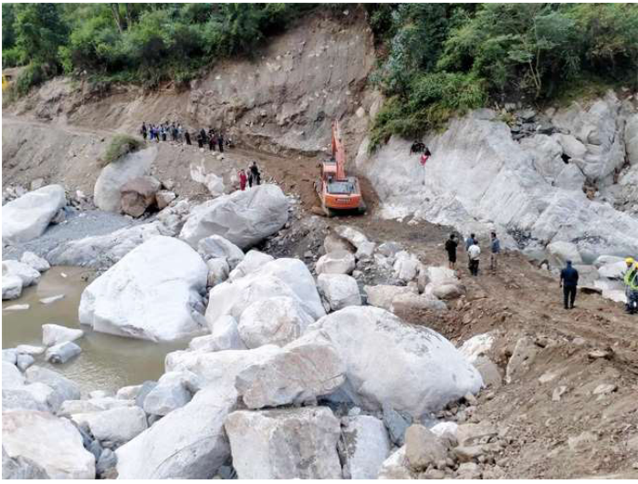
कुलेखानी-फाखेल सडकखण्डमा खोला बगाएको सडक बनाउँदै।
