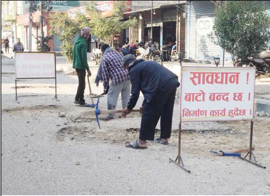
मर्मत हुँदै: हेटौडा उपमहानगरपालिकाको बजारक्षेत्र पारिजातपथमा सडक मर्मत गर्दै मजदुर। उपमहानगरले सडक बोर्डसँगको साभेदारीमा सडक मर्मत गर्न निर्माण कम्पनिसँग सम्झौता गरे पनि कार्यान्वयन हुन सकेको थिए। अहिले व्यवसायीले सडक मर्मतको कार्य सुरु गरेको छ।
