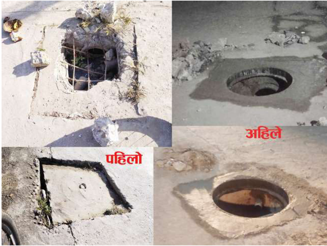
हेटौंडा-५, अब्बलडाँडामा मर्मत गर्नुअघि जोखिमपूर्ण अवस्थाको सडक (बायाँ) र मर्मतपछिको सडक (दायाँ) ।
